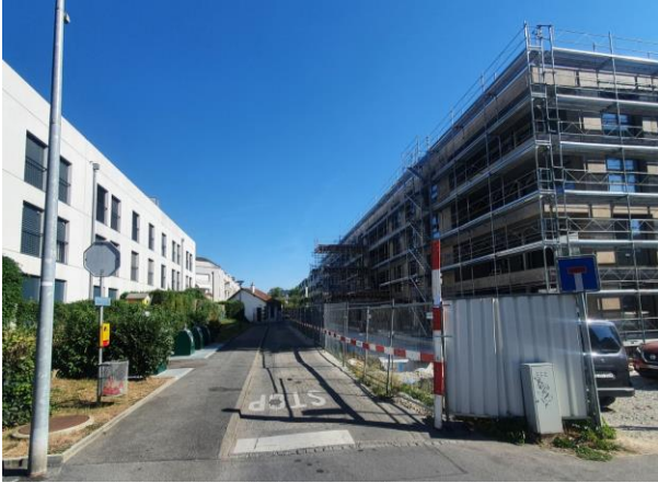
Entrée du chemin, partie sud.
