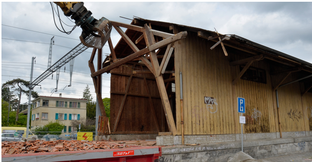
Versois Centre-Ville : démolition du Hangar CFF. Construit en 1857 puis en 1912 le hangar CFF de Versois est démolé en 2 jours !
