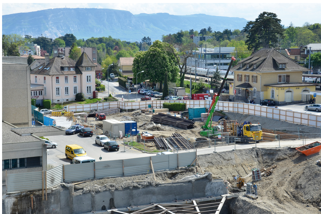
Versoix Centre-Ville, le chantier du parking et du futur bâtiment communal démarre. photo prise le 5 mai 2012
